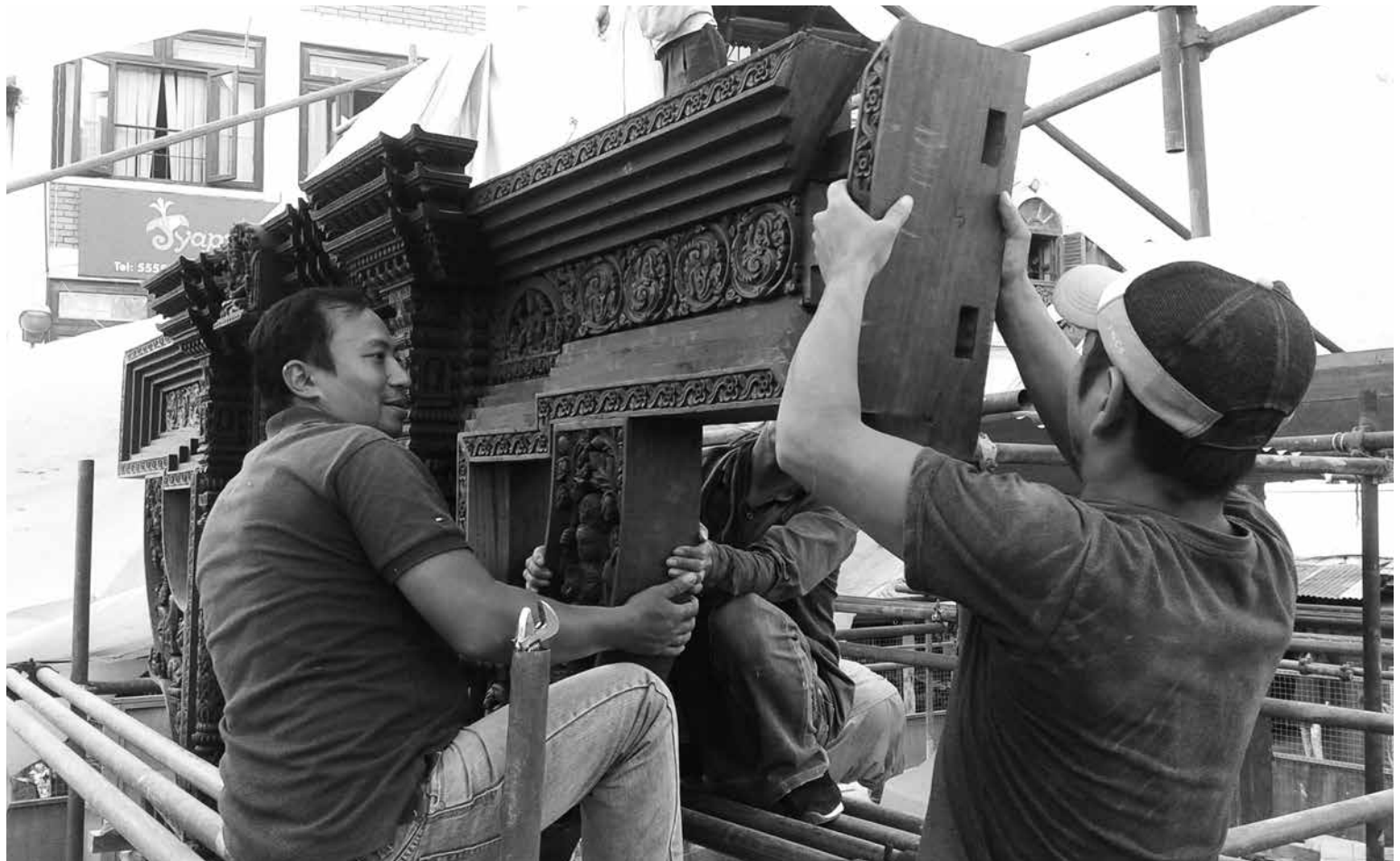
Einfügung der Türen im Rahmen der Rekonstruktion des Bhaidegah Tempels auf dem Darbâr Platz in Patan, 2018.
